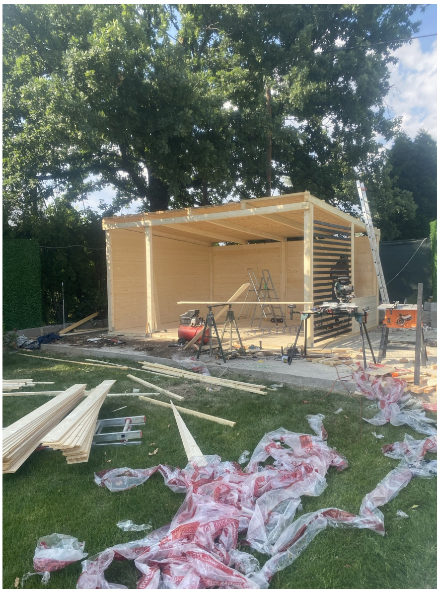
Faza izrade: noseća konstrukcija, zidne obloge, krovna podloga i priprema lamela.
