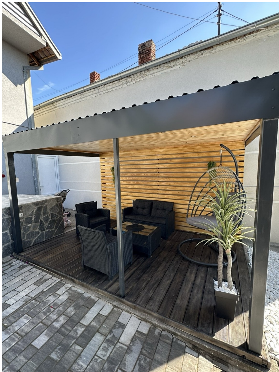
Izvedeni objekat: metalna konstrukcija sa drvenim plafonom, podom i lamelama.
